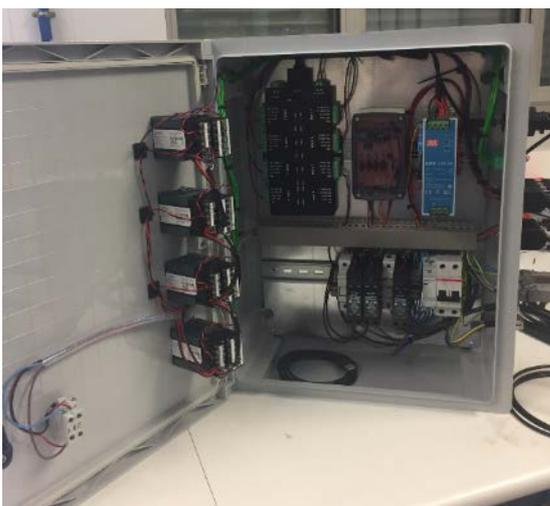
Armario de control de la planta de la termobalanza INCAR
